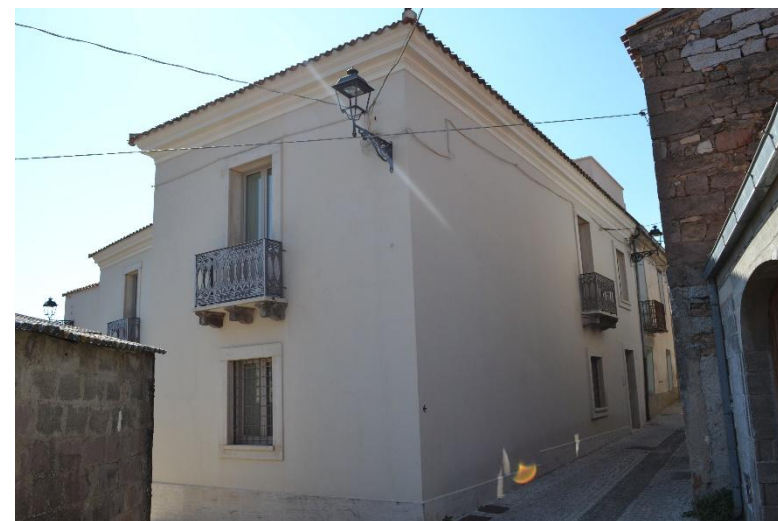
Esempi di interventi realizzati in facciata rilevati all'interno dell'edificio storico
